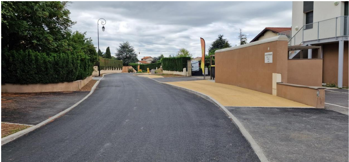
Revêtement des trottoirs en véridrain (perméable) – Mise en œuvre de galets sciés
