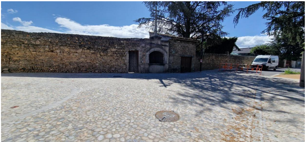
Revêtement des trottoirs en véridrain (perméable) – Mise en œuvre de galets sciés
